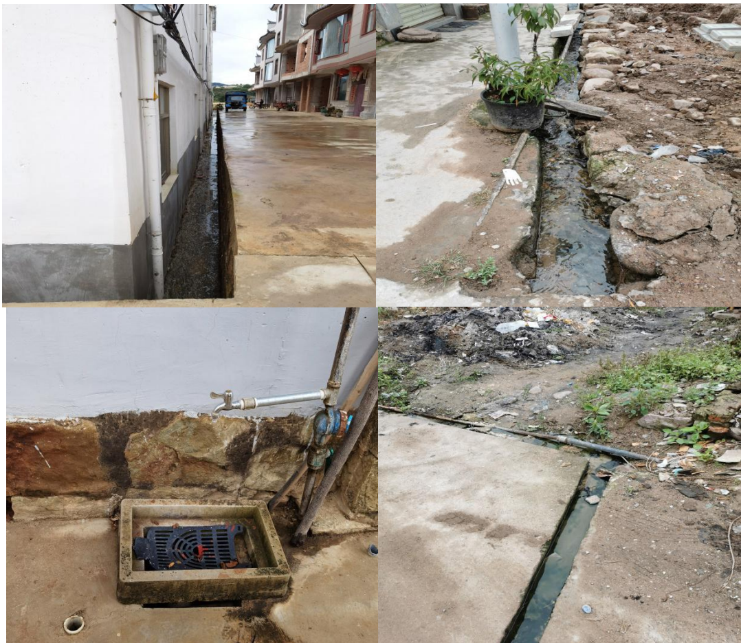
照片4 生活污水污染现状
